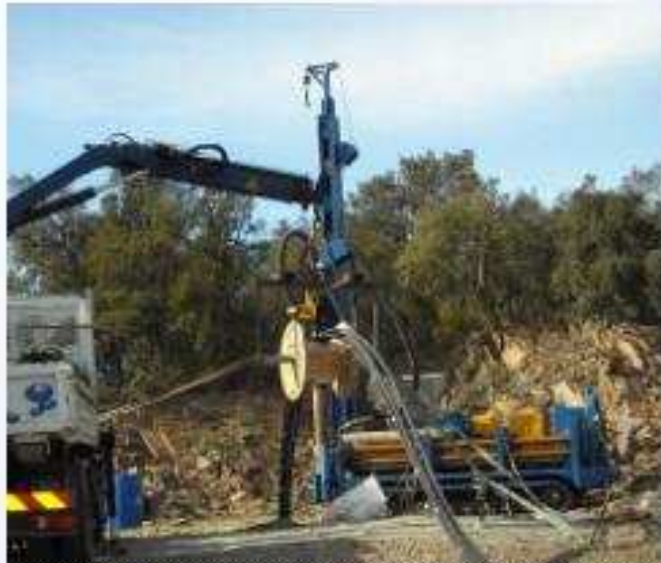
Mise en place d'une sonde géothermique
